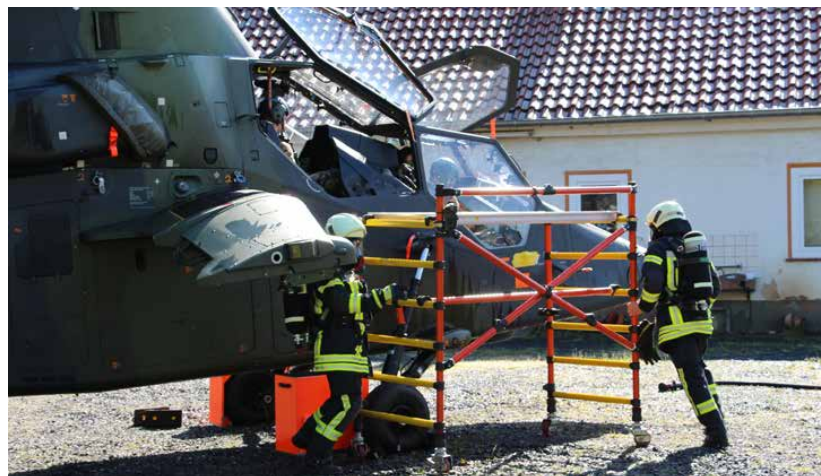
Die verletzten Soldaten können nur über eine Arbeitsbühne erreicht werden, die die Feuerwehr binnen weniger Minuten aufstellt.
