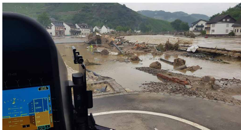
Die Trümmer vor dem Hubschrauber lassen erahnen, dass hier einst eine Brücke über die Ahr führte, die von Wassermassen und Unrat völlig zerstört worden ist.
